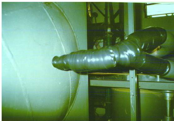
Figura 1.7 - Entrada e saída do etileno-glicol de dentro da câmara de vácuo.
