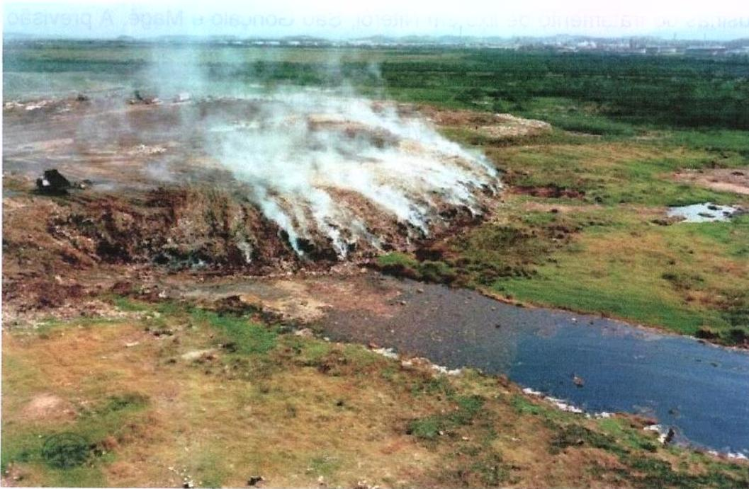
**Figura 4:** Vazamento de chorume do aterro de Gramacho atingindo manguezais.
