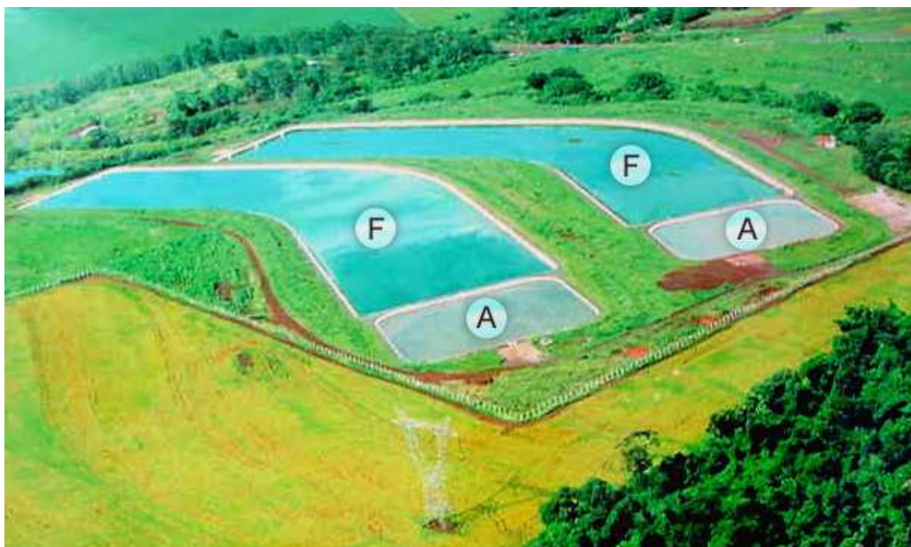
Figura 1. Foto aérea da Estação de Tratamento de Esgoto (ETE) da Cia de Saneamento Básico do Estado de São Paulo - SABESP/Assis - (A = lagoas anaeróbias; F = lagoas facultativas).
