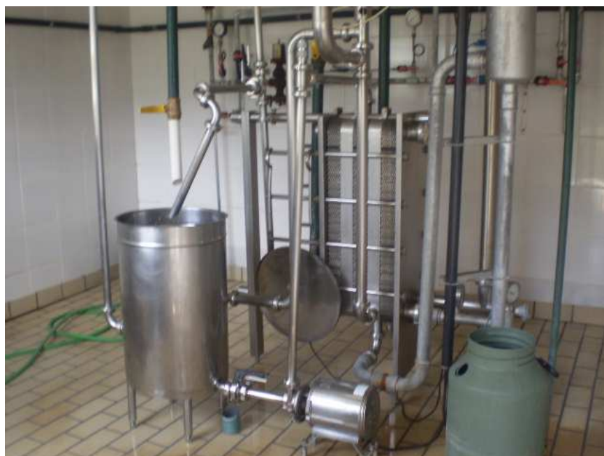
Figura 12. Trocador de calor a placas.
