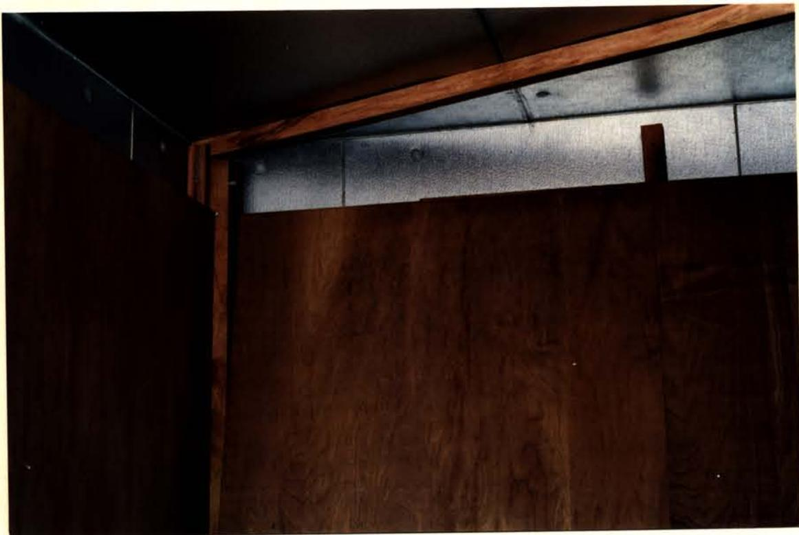
**Figura IV.3 - Detalhe de uma das quatro vigotas e do caibro utilizadas como estrutura das paredes da camisa e o teto**
