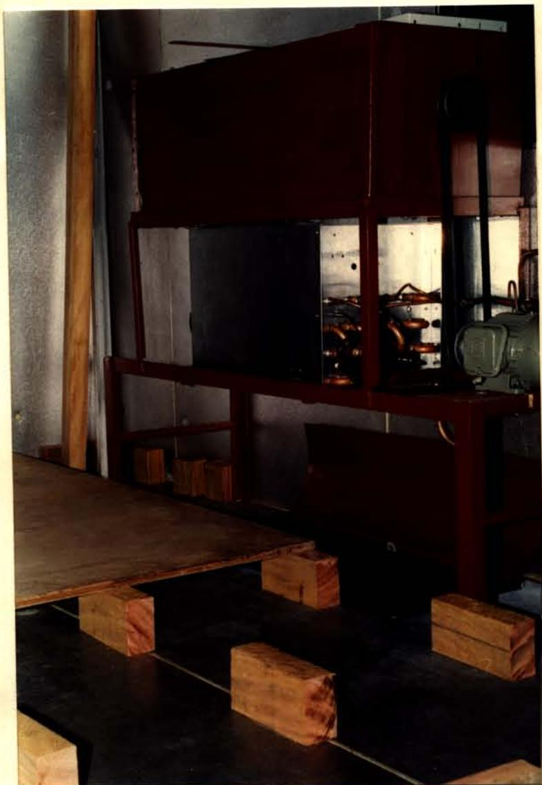
**Figura IV.2a - Detalhe da montagem do piso, vendo-se ao fundo os tubos do evaporador e a armação do ventilador, embutidos no lado E da câmara.**
