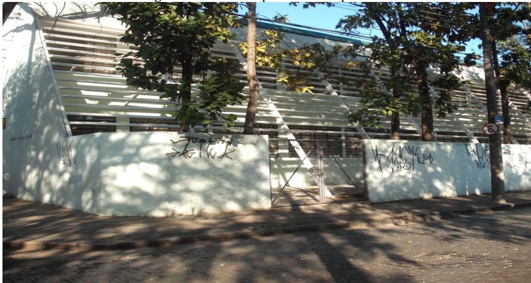
Figura 42: Lateral do prédio - 5º Grupo Escolar
