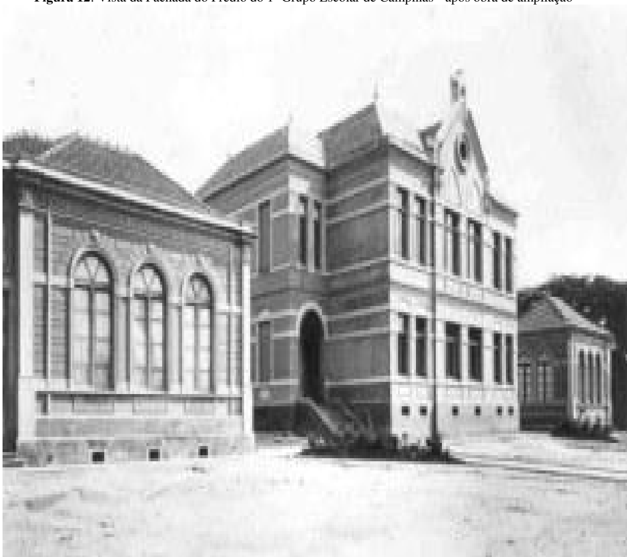
Figura 12: Vista da Fachada do Prédio do 1º Grupo Escolar de Campinas - após obra de ampliação
