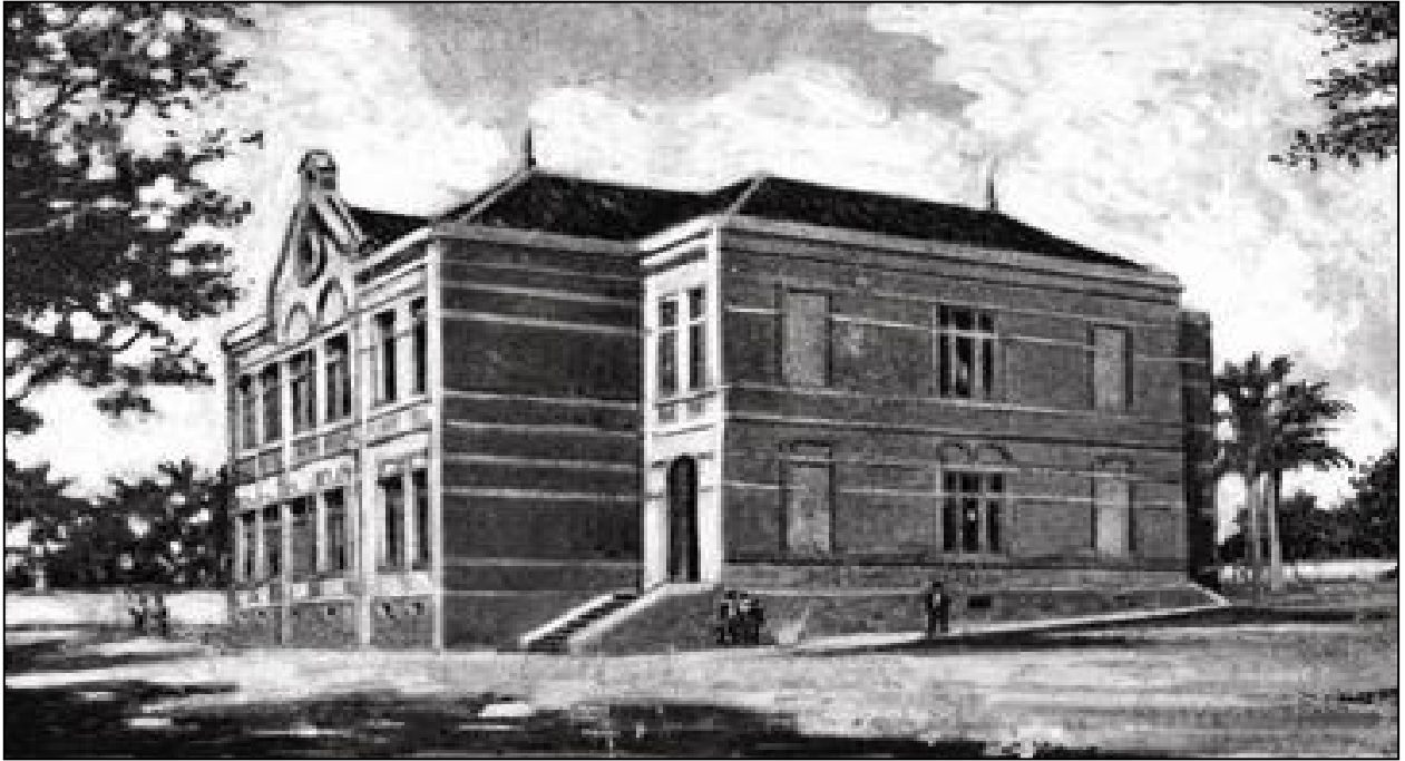
Figura 10: Vista da Lateral direita do Prédio do 1º Grupo Escolar – rua sem pavimentação
