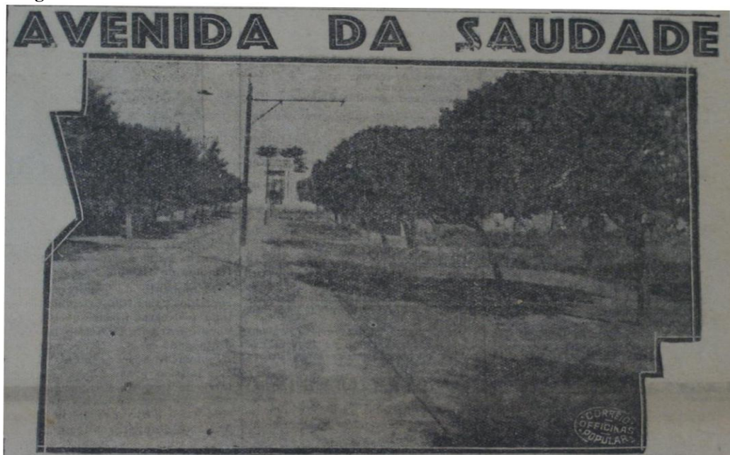
Figura 43: Vista Parcial da Avenida da Saudade e ao fundo o Portal do Cemitério da Saudade
