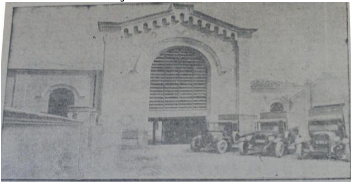
Figura 33: Matadouro – Vila Industrial
