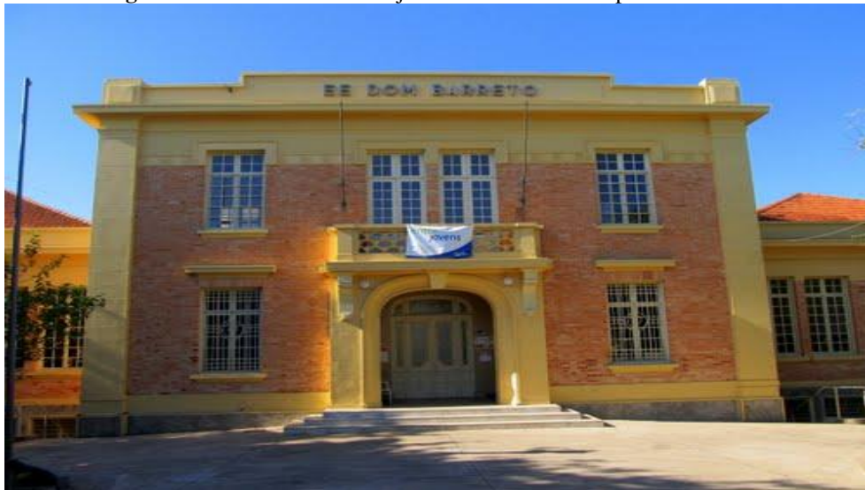
Figura 49: Fachada do Prédio já reformado do 6º Grupo Escolar – 149
