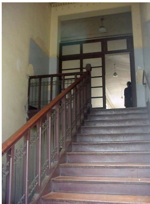
Figura 20 - Detalhe de uma das escadarias internas.
