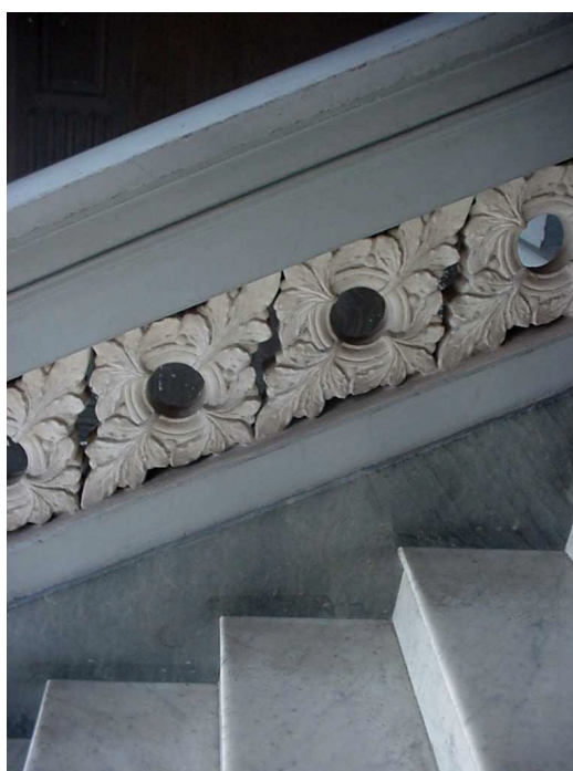
Figura 21 - Detalhe da escadaria principal.
