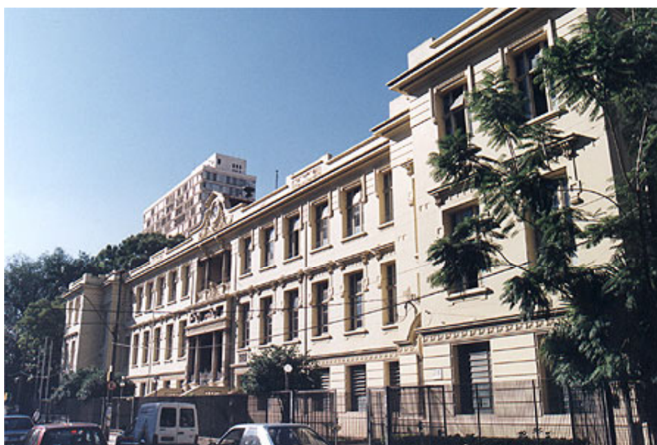
Figura 26 – A atual grade em torno da Escola Estadual “Carlos Gomes” não existia quando o edifício foi inaugurado em 1924 52 .
