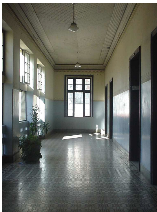
Figura 19 - Detalhe de um dos corredores 50 .
