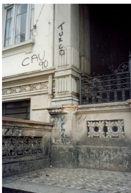
Figura 32 - Situação do prédio da EE "Carlos Gomes" em dezembro de 1995, antes da reforma empreendida com o apoio da “Associação dos Amigos da Escola Carlos Gomes”.
