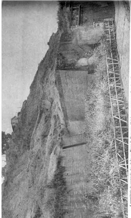
A experiência de construção dos aludés no Morro do Queirozene (foto), com muros, remilhou improficaz: o deslizamento se fez por cima da muralha.
