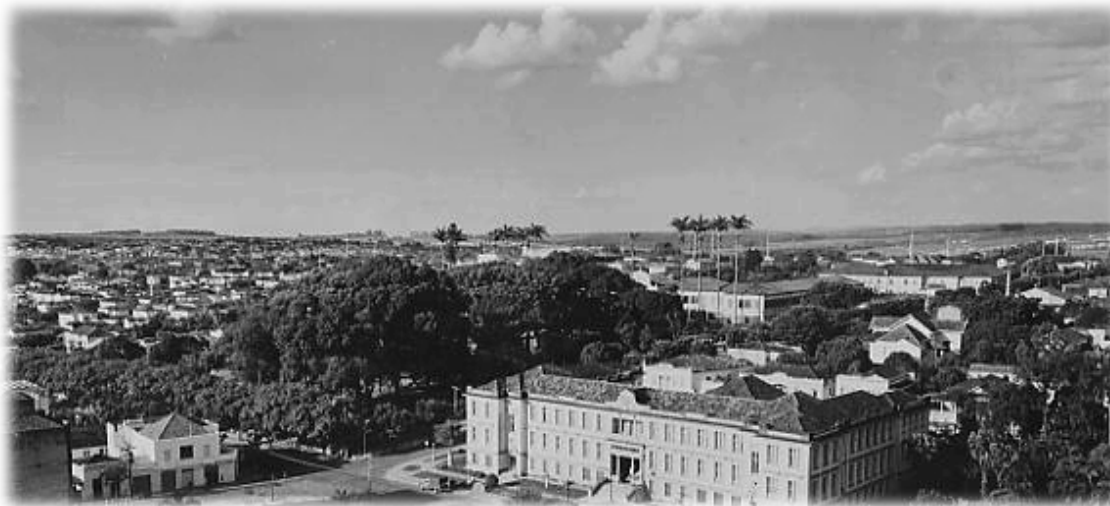
Figura 23: No plano posterior, o prédio do Asilo de Órfãos, anexo à Capela, tendo à frente quatro palmeiras e frondoso arvoredado, onde ficava o pomar, hoje, Prefeitura Municipal, ao lado da antiga Escola Normal . 1945. Fonte: Arquivo De Biasi.
