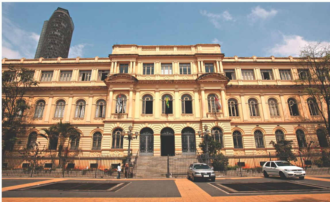
Foto 8 — Prédio Caetano de Campos, na Praça da República do município de São Paulo, 2012.
