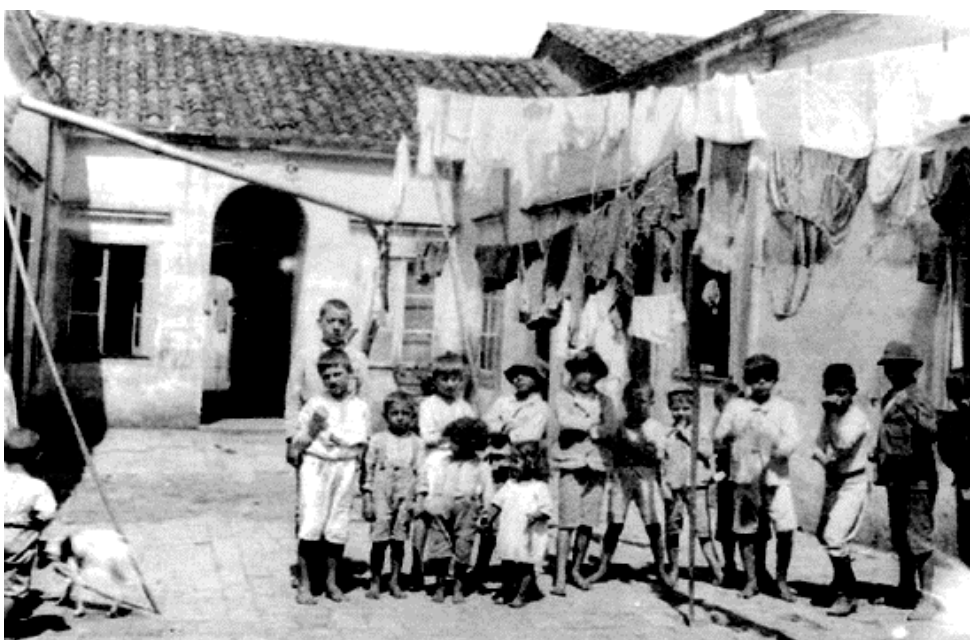
Fig. 7: Cortiço na Rua da Abolição (aproximadamente década de 1930)
