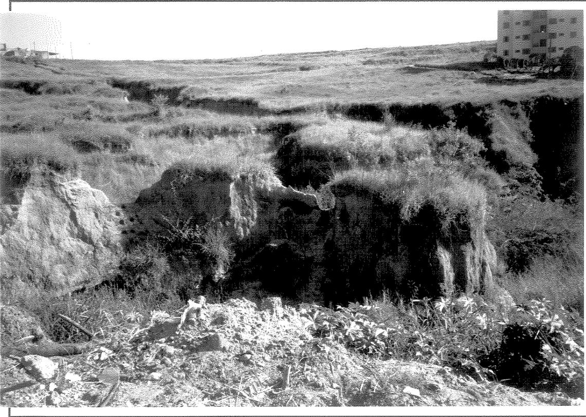
FIGURA 44 - FOTO 22. Visão parcial de uma área de "voçorocamento", processo intenso de erosão, geralmente causado pelo desmatamento e terraplanagem e por lançamento de esgoto (sem canalização e tratamento adequado).
