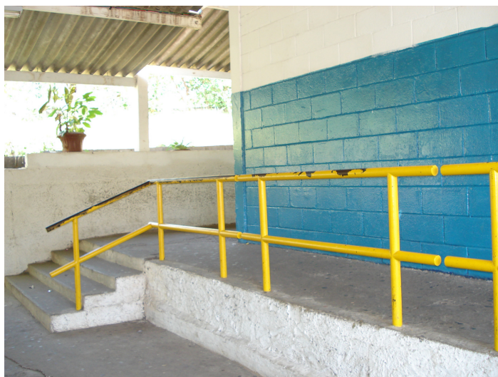
Foto da rampa que dá acesso ao segundo pavimento e ao refeitório.
