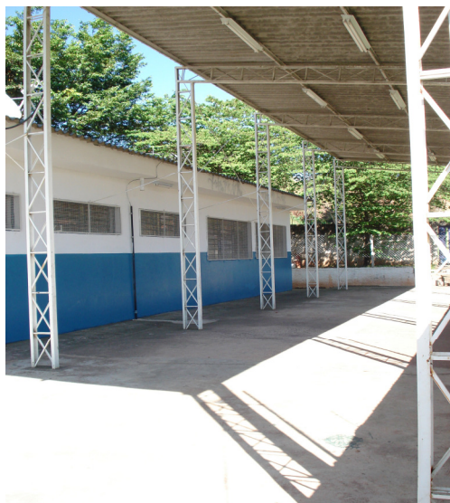
Foto da “quadrinha” tirada da entrada da rampa de acesso.
