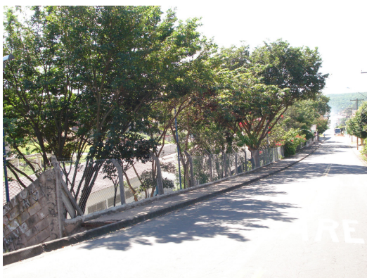
Foto da porção superior da escola e a rua principal.
