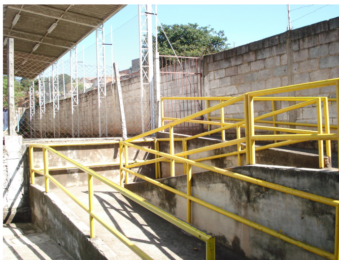
Foto da rampa de acesso ao terceiro pavimento, ao fundo a “quadrinha”.
