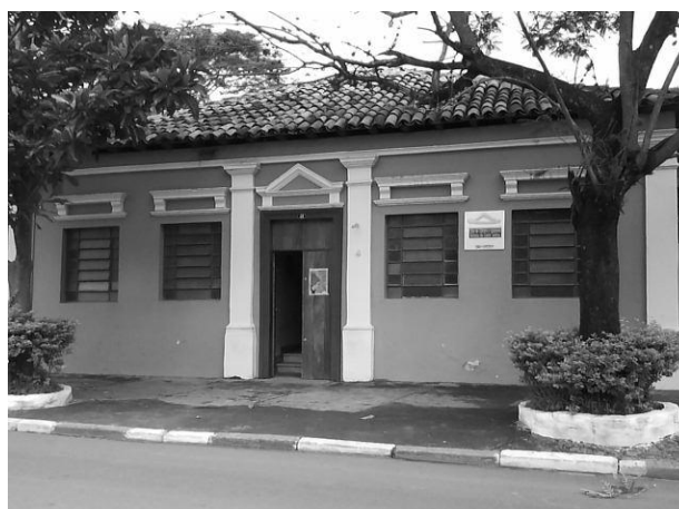
Foto 3 – Fachada Restaurada do Grupo Escolar - 1925
