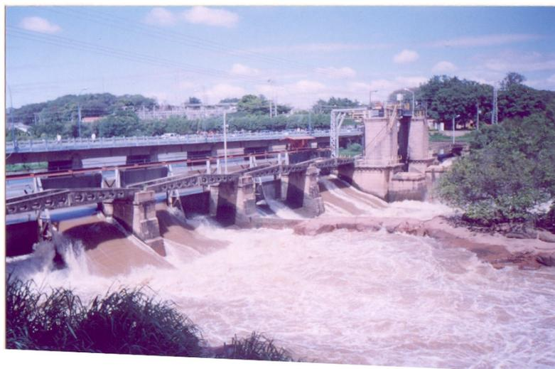
FOTO 05: Comportas de represamento das águas do rio Tietê.
