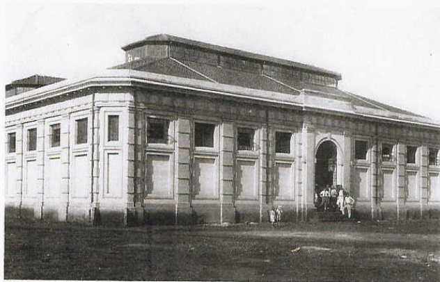
Antigo Mercado Municipal destruído por um incêndio
