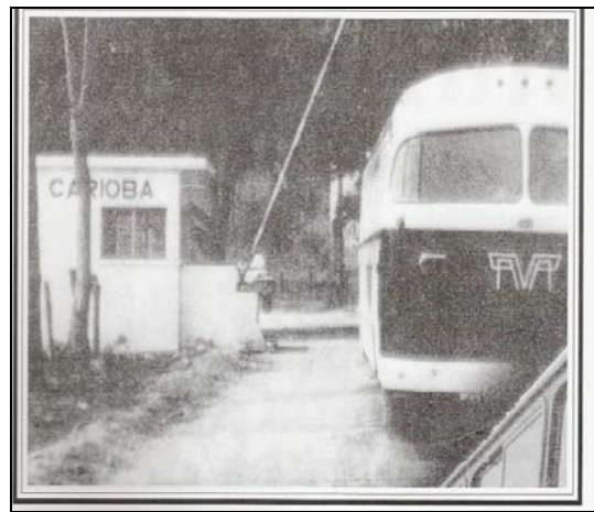
Fig. 12. Entrada do bairro Carioba
