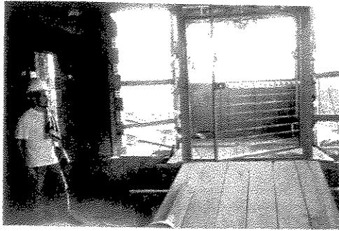
Detalhes: cancela instalada em todos os pavimentos. Porta só abre com a chegada da caçamba do elevador de carga.
