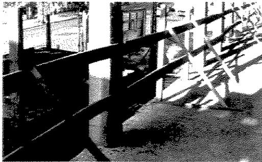
Detalhes: instalados guarda-corpos e barra intermediária para evitar queda de trabalhadores da periferia da edificação. Falta de rodapé de 20cm para evitar queda de objetos.
