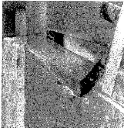
**Detalhes:** rebaixamento do madeirite mostra onde o trabalhador teve esmagamento craniano (Seta amarela). Manchas de sangue aparecem na tela que reveste a torre e nas travessas da estrutura da torre metálica.
