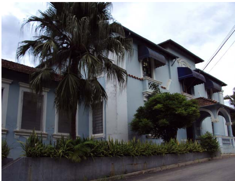
Figura 1. Fachada do Serviço de Saúde Dr. Cândido Ferreira, localizado no distrito de Sousas – Campinas, SP.
