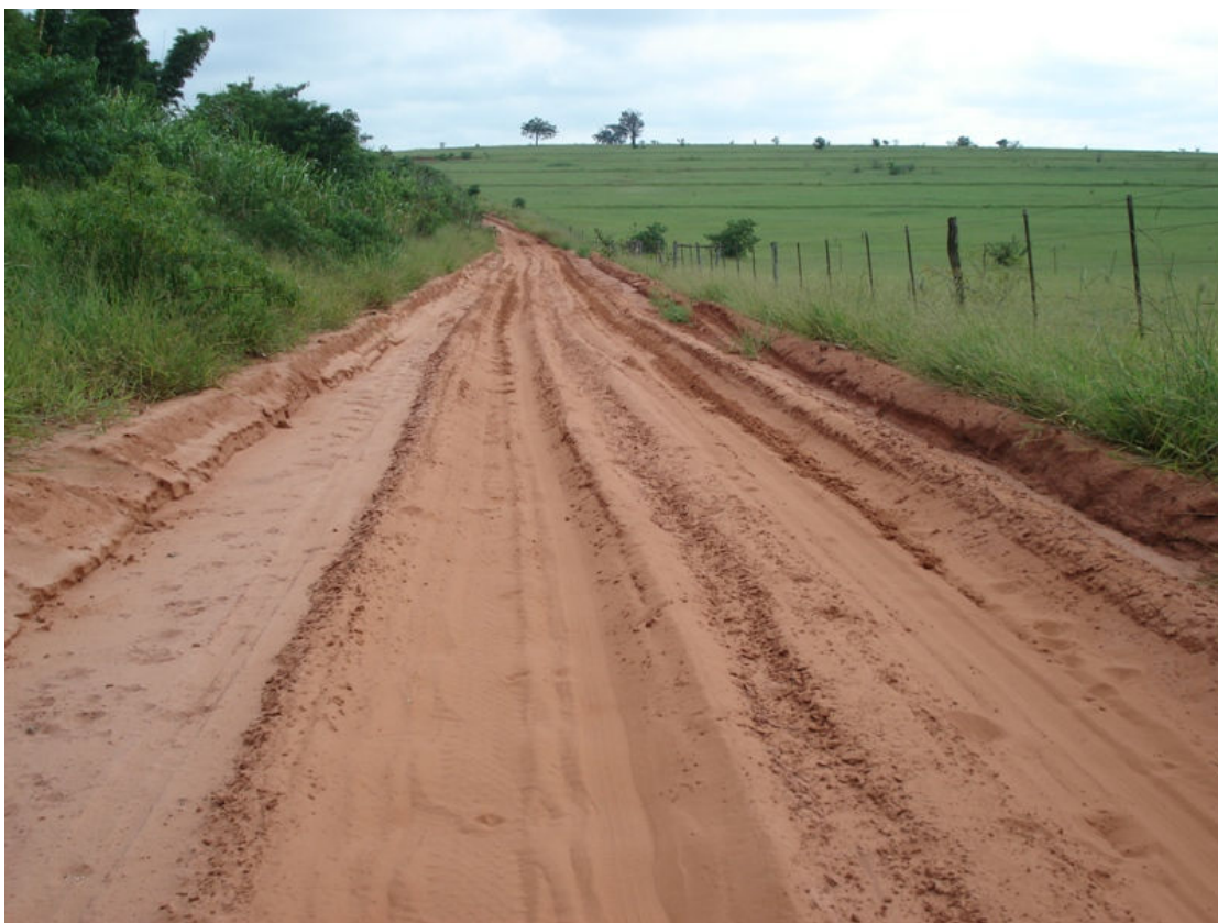
Figura 15 - Vista do segundo trecho de areião – BRU 011.
