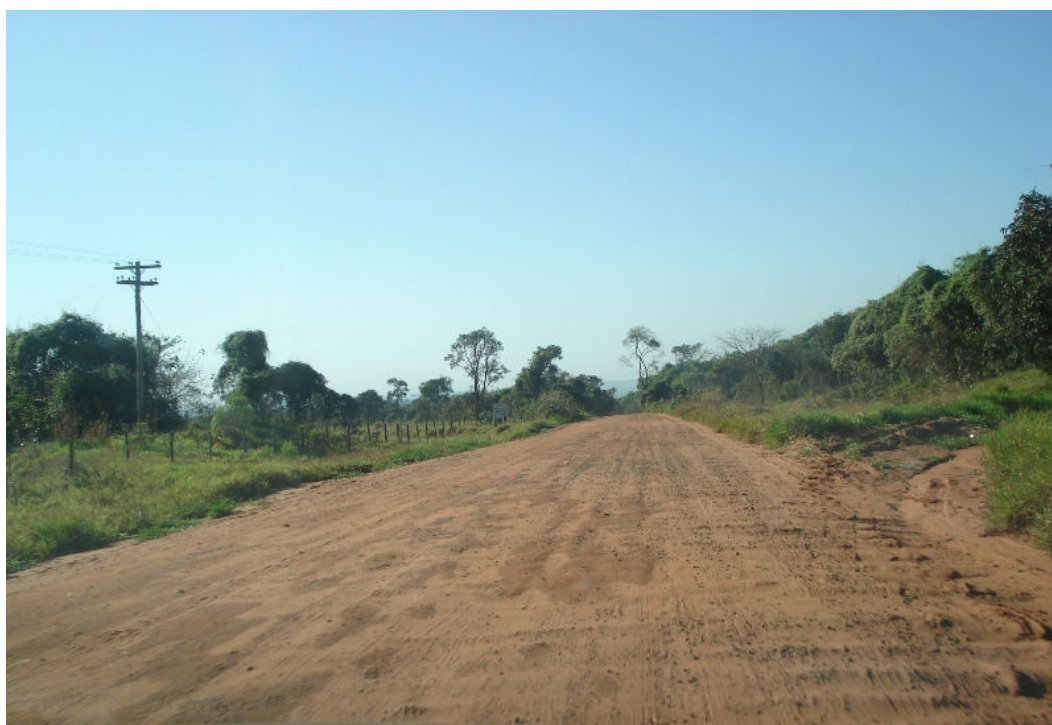
Figura 3 – Início do trecho não-pavimentado da estrada BRU 026.
