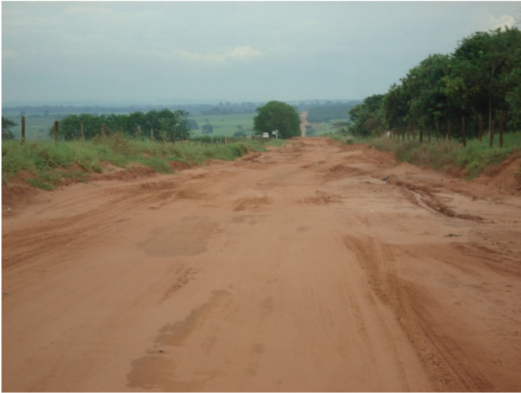
Figura 8 - Início do trecho não-pavimentado – BRU 001.
