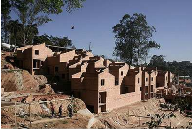
Estágio atual da obra
