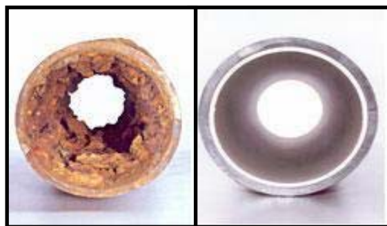
Figura 4.10: Tubulação reabilitada com argamassa de cimento
