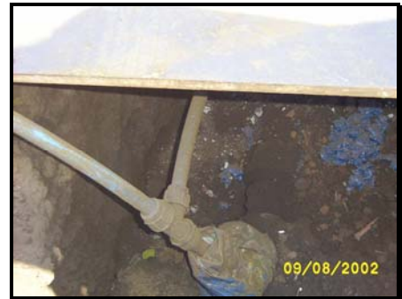
Figura 4.20: Detalhe de engate na rede
