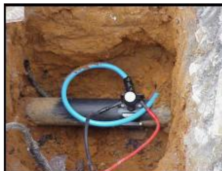
Figura 4.30: Processo de eletro-fusão
