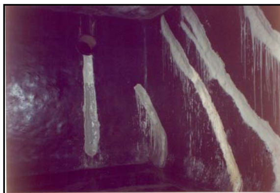
Figura 3.4: Aplicação de resina em trinca de reservatório
