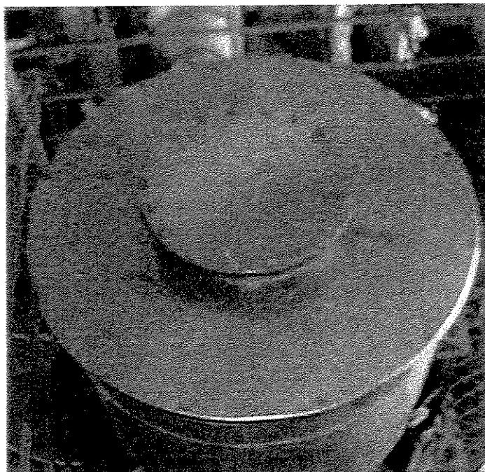
Figura 4.6 - Vista de topo do Silo SI 01
