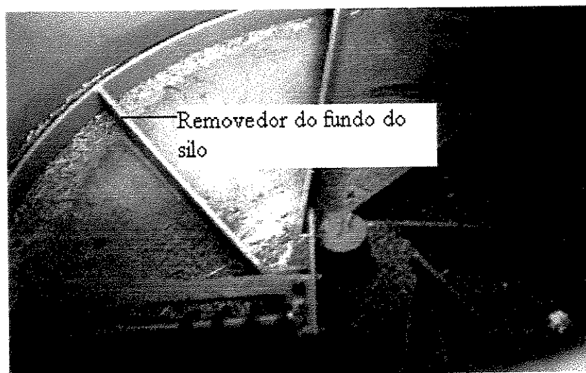
Figura 11 Fotografia do removedor do fundo do silo
