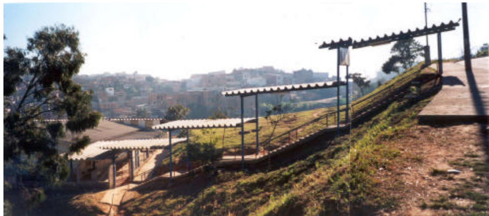
cota de acesso acima do platô da edificação
