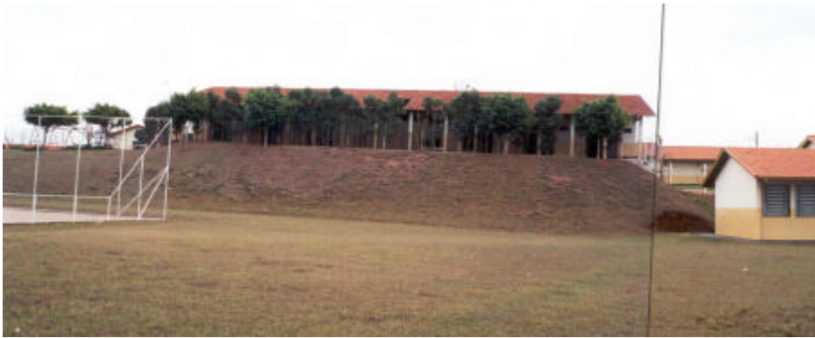
Foto 3. 3: exemplo de alteração do perfil natural do terreno.
