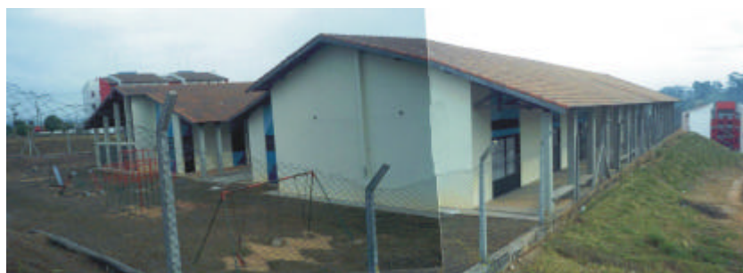
Foto 3.4: exemplo de talude sem orla de contorno.
