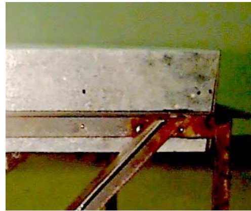
Figura 6.2: Detalhe dos rebites (pop) de fixação da placa.
