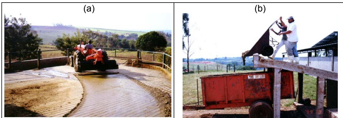
Figura 26- Fotos de raspagem mecânica (a) e manual (b).
