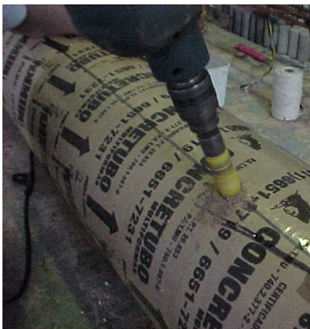
Figura 4.19- Perfuração da forma
