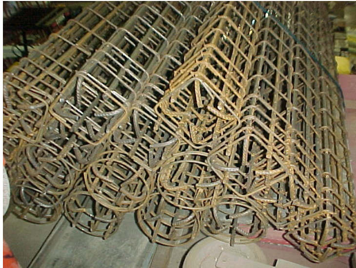
Figura 4.14 - Armaduras dos pilares
