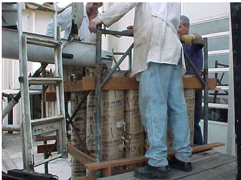
Figura 4.22- Posicionamento do caminhão betonaira
