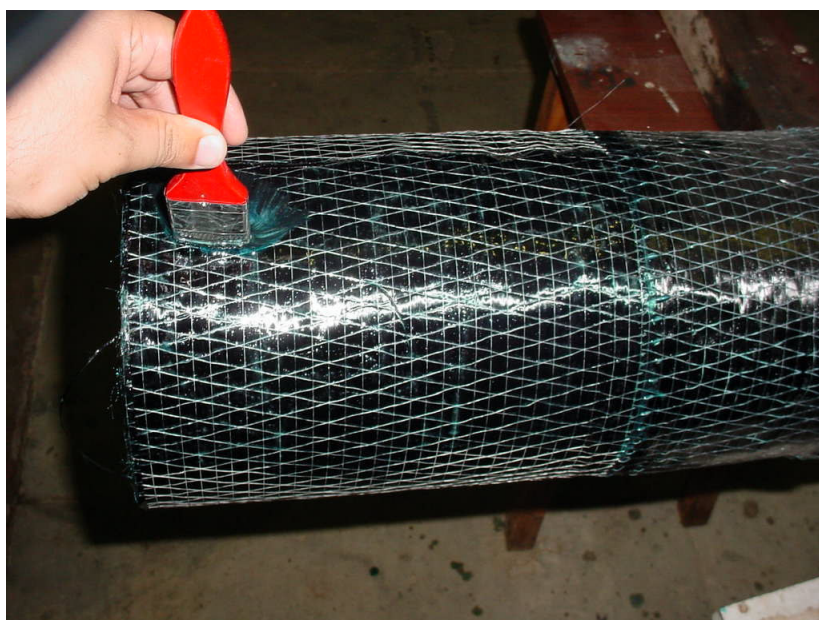
Figura 4.34- Aplicação de resina saturante
