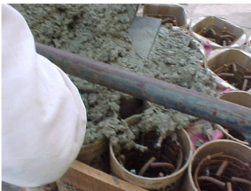
Figura 4.23- Lançamento do concreto
