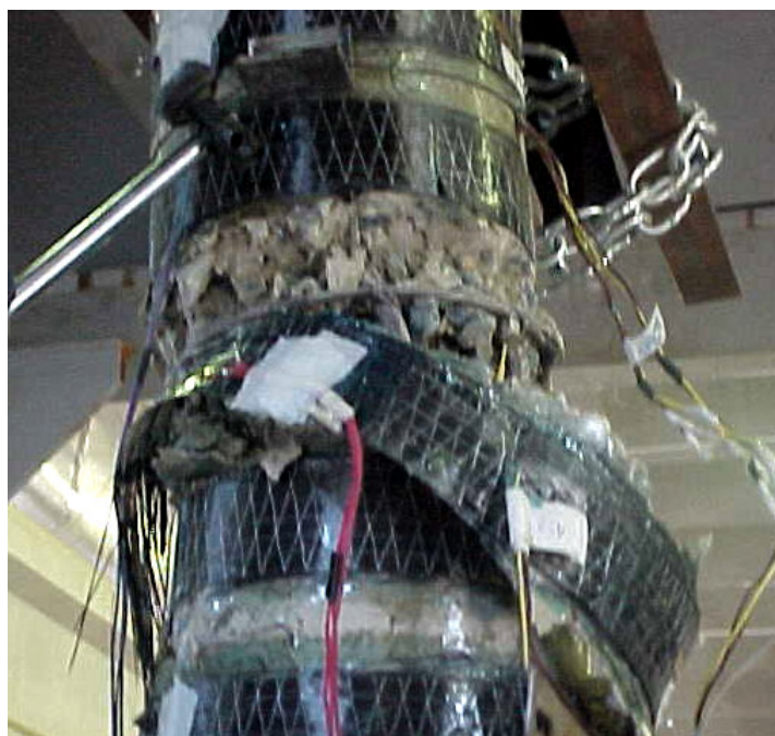
Figura 5.9 – Detalhe de ruptura PC02S'5
