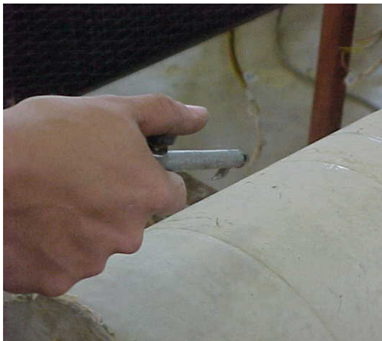
Figura 4.28- Limpeza com jato de ar
