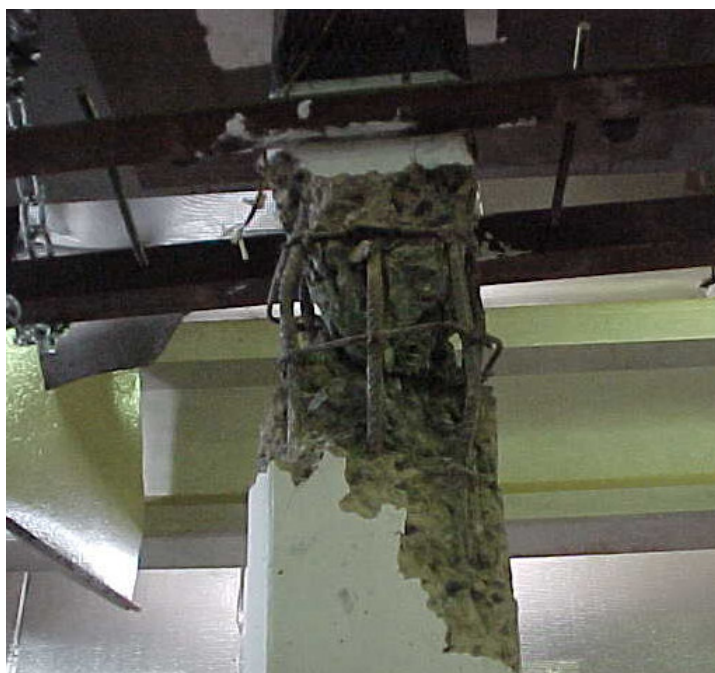
Figura 5.19 - Detalhe da ruína PQT
