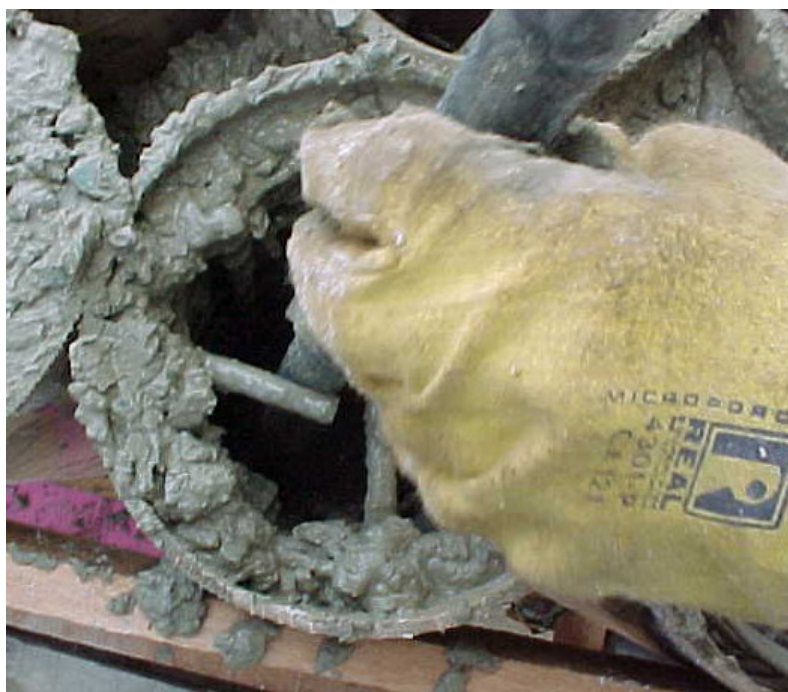
Figura 4.24- Adensamento do concreto com vibrador
