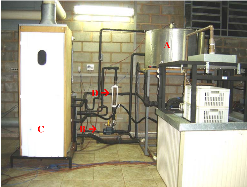
Figura 6.12: Sistema de aquecimento por água quente. A = tanque reservatório; B = bomba centrífuga; C = secador de bandejas; D = rotâmetro.
