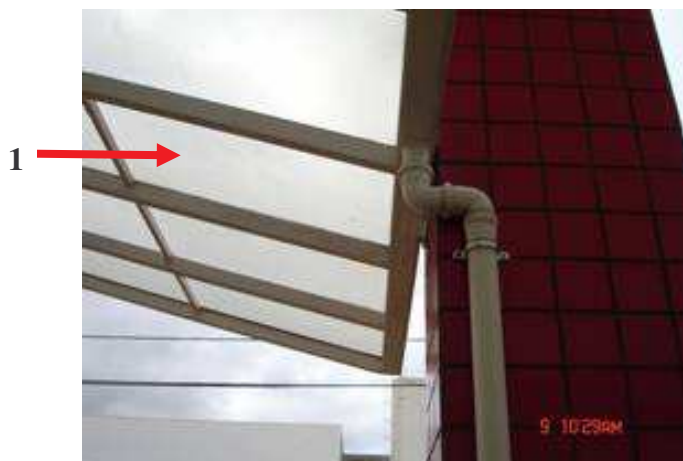
Figura 2. Telhado da Fábrica Grafimec (Ponto de Coleta 1).
