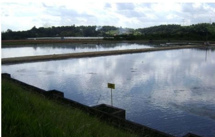
FIGURA 4.9: Lagoas de decantação n.º03 (em primeiro plano) e n.º04.
