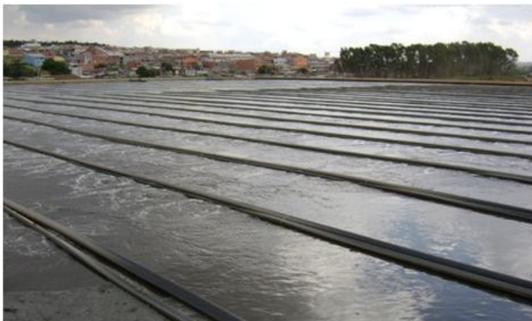
FIGURA 4.8: Lagoa de aeração n.º01.
