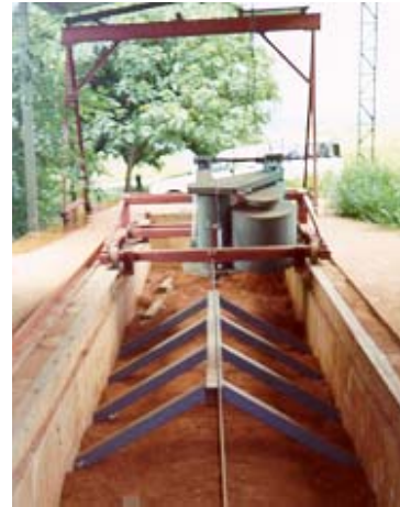
Figura 32: Estrutura de cavaletes
