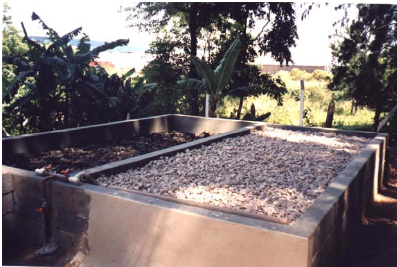
Figura 6. Vista dos leitos cultivados com pneu e brita como meio suporte.
