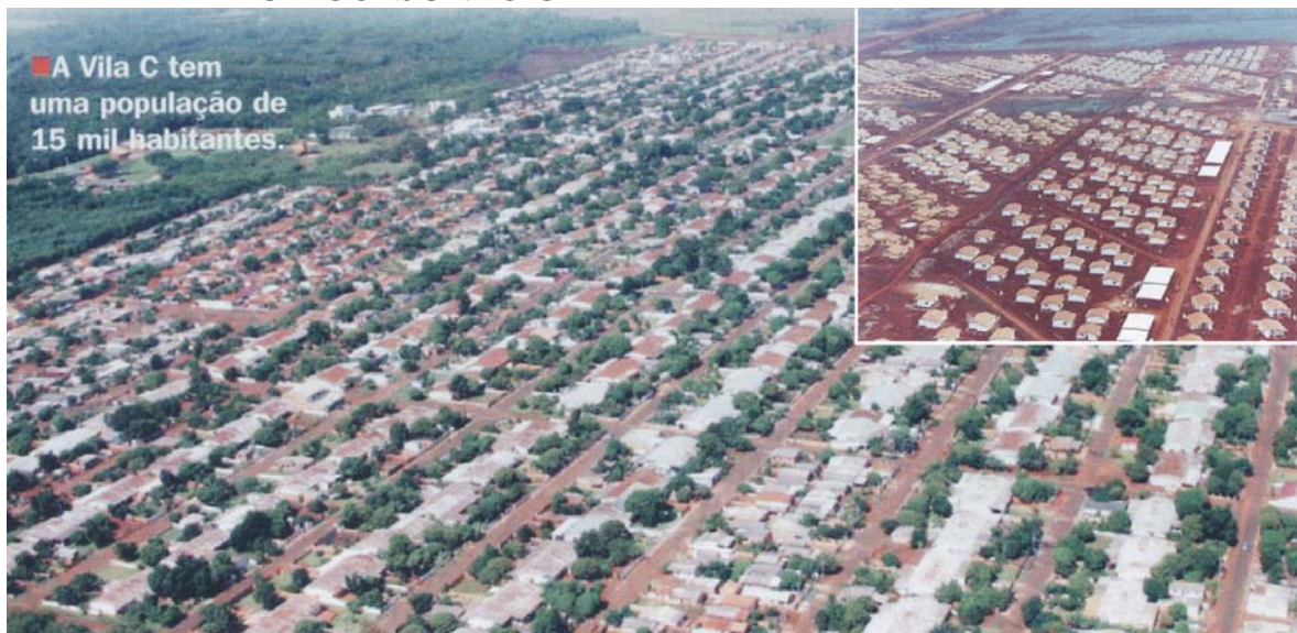
Figura 10 - VILAS CONSTRUIDAS PARA MORADIA DOS TRABALHADORES DA ITAIPU – CONJUNTO C E A
