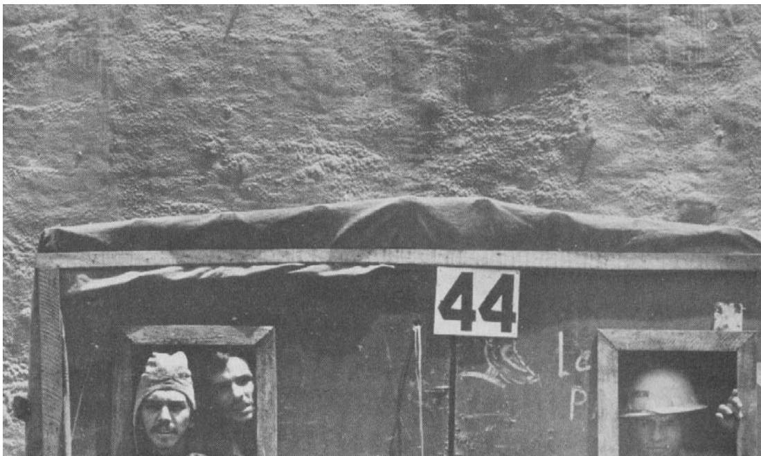
Figura 8 - A CAMINHO DO CANTEIRO DE OBRAS: TRANSPORTE DOS BARRAGEIROS
