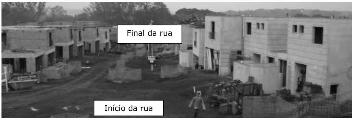
Figura 5.14 Foto ilustrando o seqüenciamento de execução – obra F
