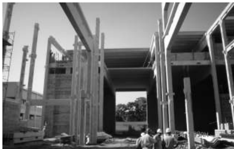
Figura 4.7 Obra B – Foto
