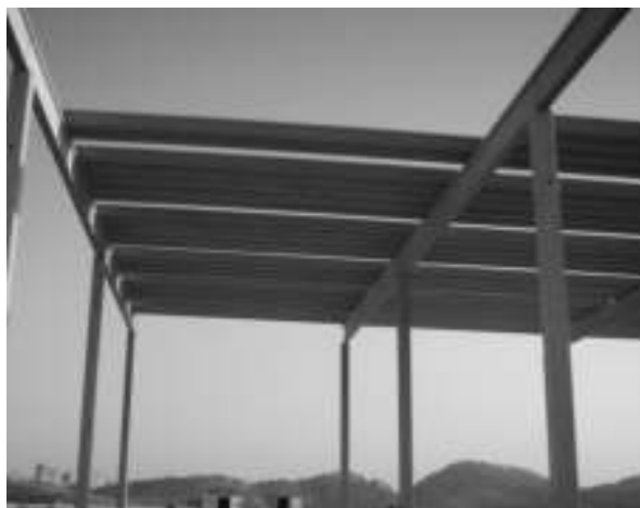
(a) Pequeno lote de montagem da estrutura
