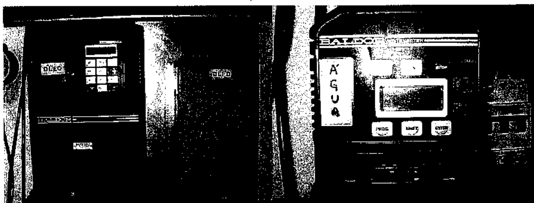
Figura 5.3- Inversores de frequência.
