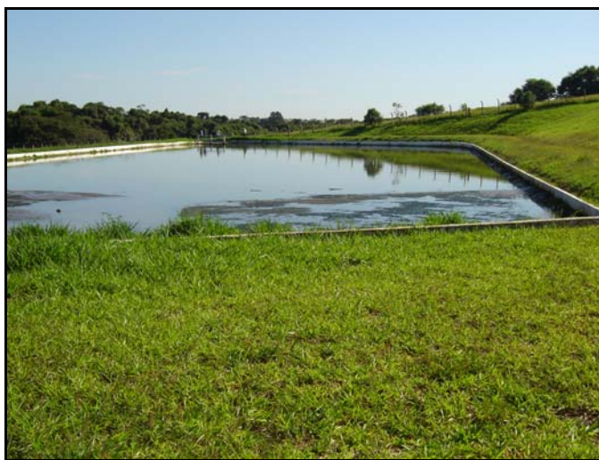
Figura 4.18 - Vista da ETE City Petrópolis, Franca-SP, operada pela SABESP (Fonte: AUTOR, 2008)
