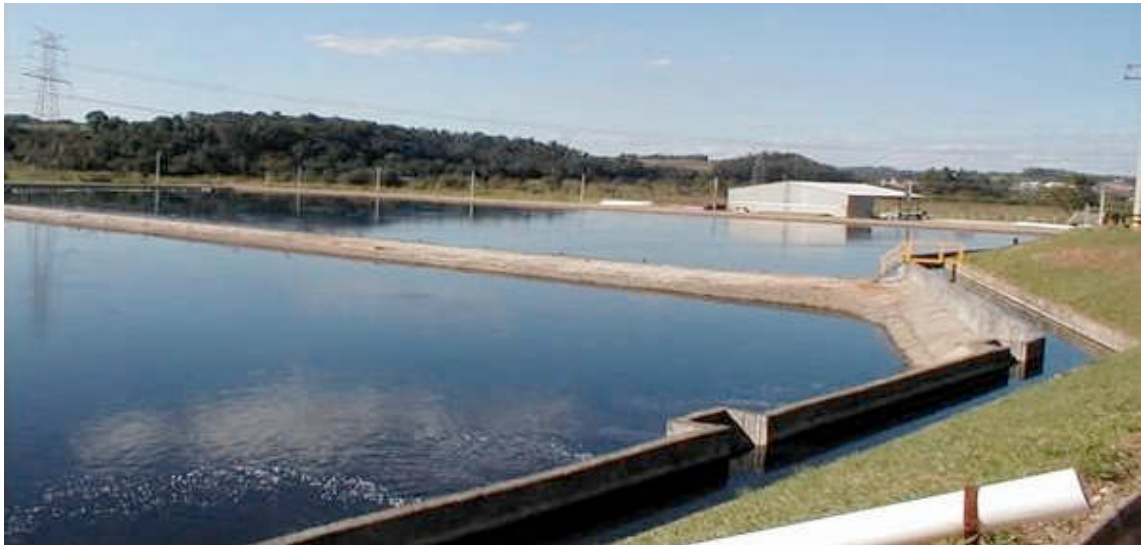
Figura 3: Lagoas de decantação.
