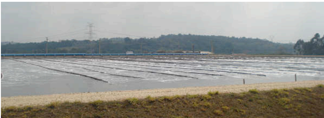
Figura 2: Lagoa aerada de mistura completa.
