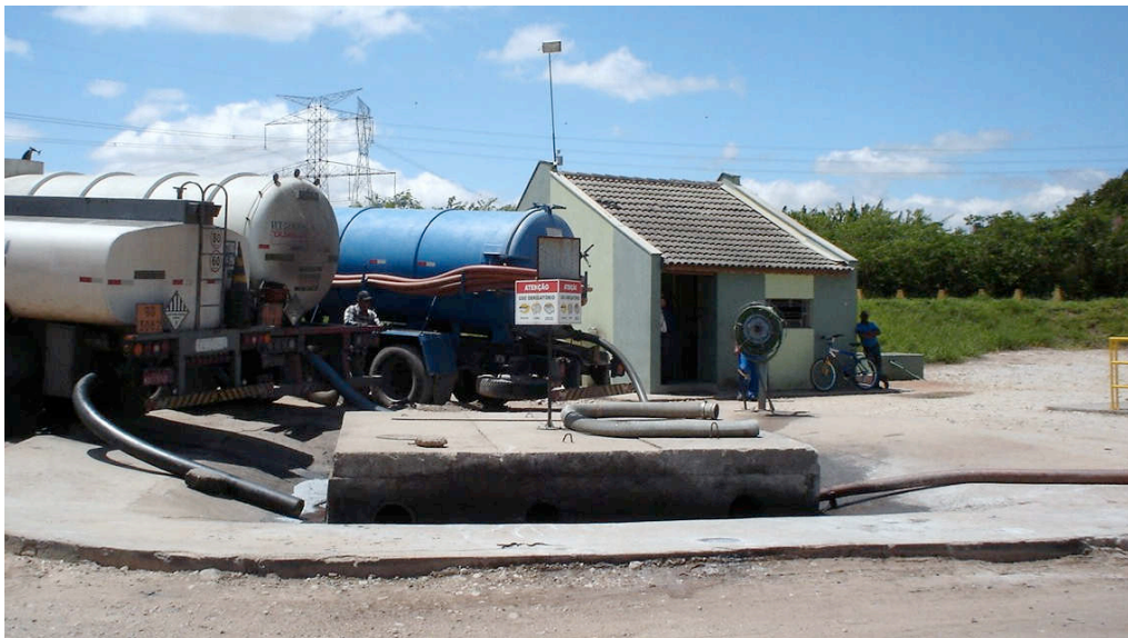
Figura 5: Despejo de efluentes por caminhões na ETEJ.
