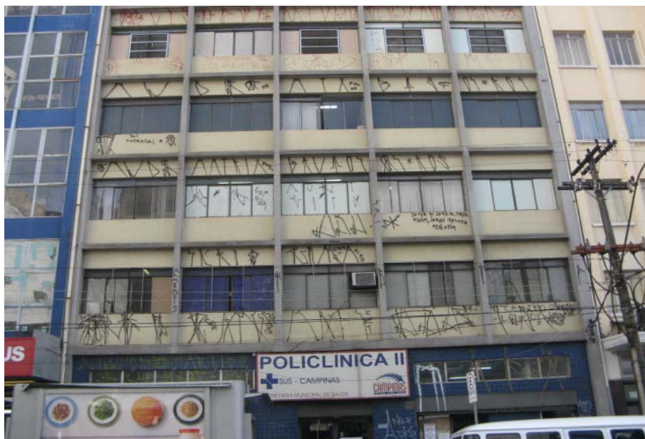
Figura 21 – Prédio Centro Campinas
