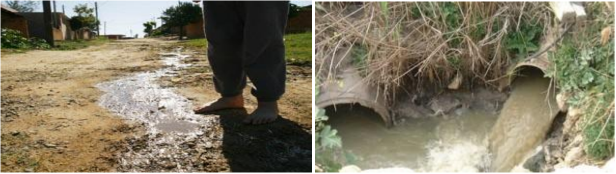
Figura 10 – Fotos - Esgoto a céu aberto em Campinas Fonte: http://www.portalcbn Campinas.com.br/?p=8731
