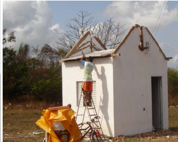
Figura 3.7 Foto do protótipo com telhado na inclinação 15°.
