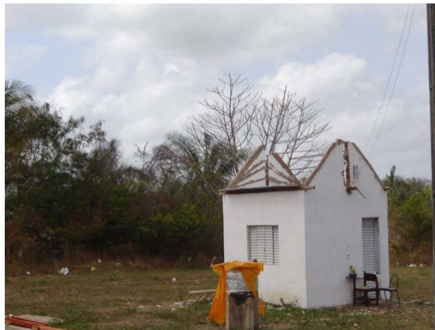
Figura 3.8 Foto do protótipo com telhado na inclinação 0°.
