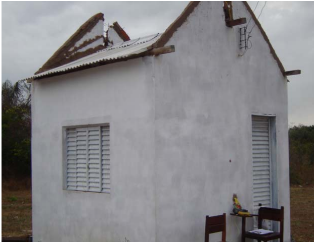
Figura 3.6 Foto do protótipo com telhado na inclinação 25°.
