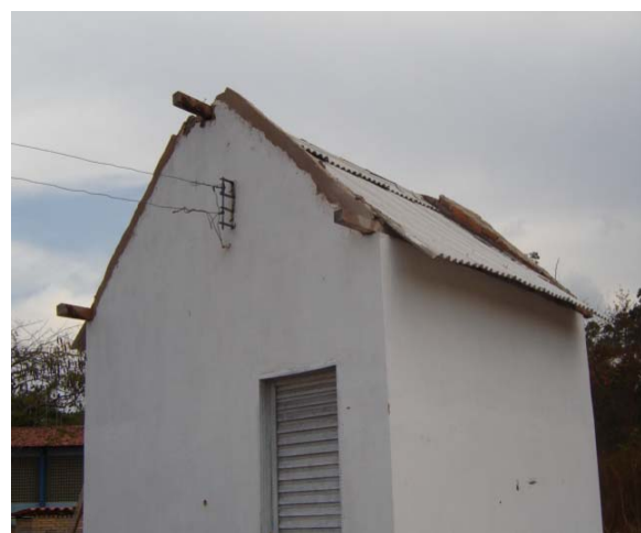
Figura 3.4 Foto do protótipo com telhado na inclinação 35°.
