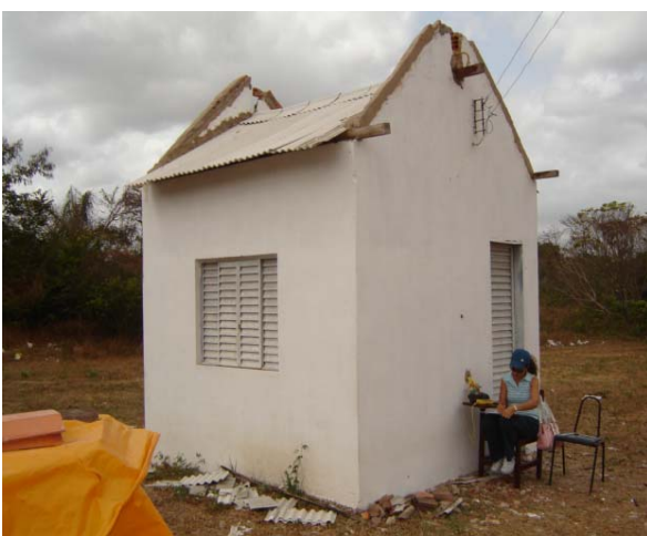
Figura 3.5 Foto do protótipo com telhado na inclinação 30°.
