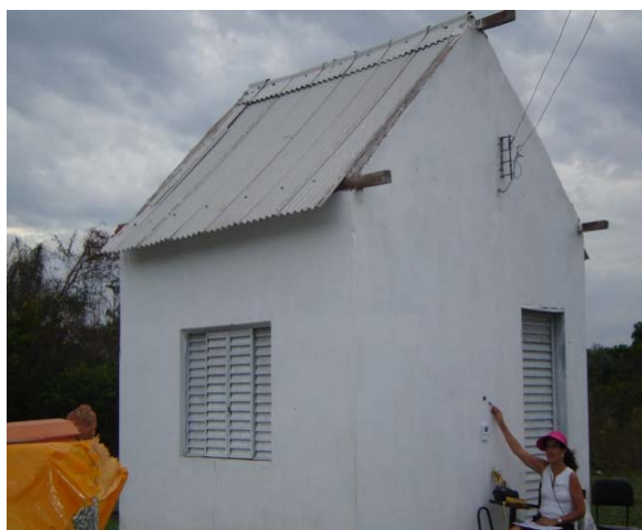
Figura 3.2 Foto do protótipo com telhado na inclinação 45°.
