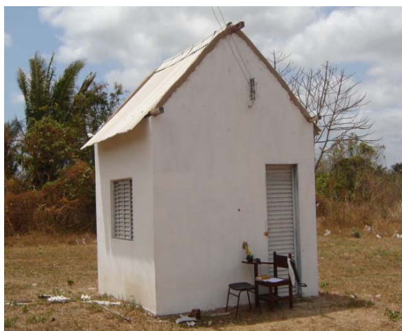
Figura 3.3 Foto do protótipo com telhado na inclinação 37,5°.
