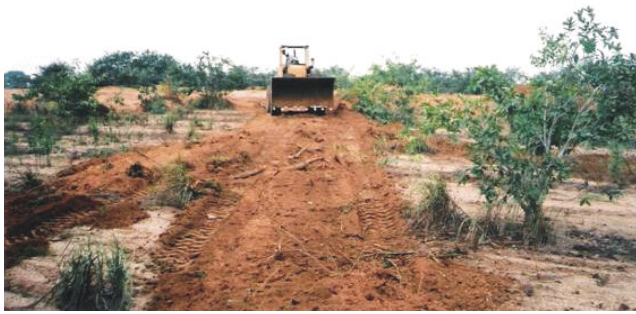
FIGURA 23 - Pá carregadora em operação de capeamento
