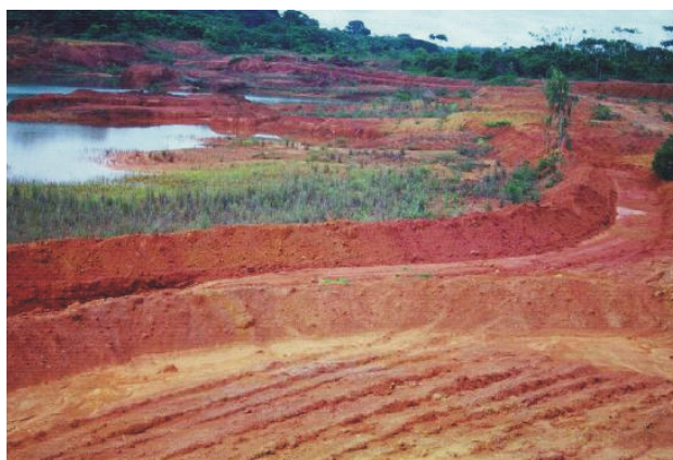
FIGURA 18 - Recomposição topográfica e preparo superficial da área
