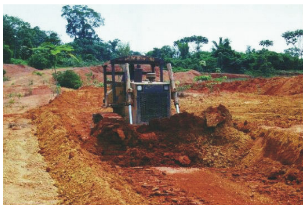
FIGURA 17 - Trator com lâmina operação de terraceamento
