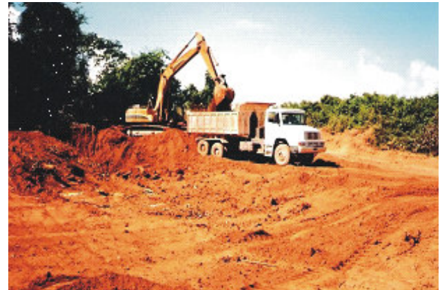
FIGURA 22 - Operação de remoção e transporte
