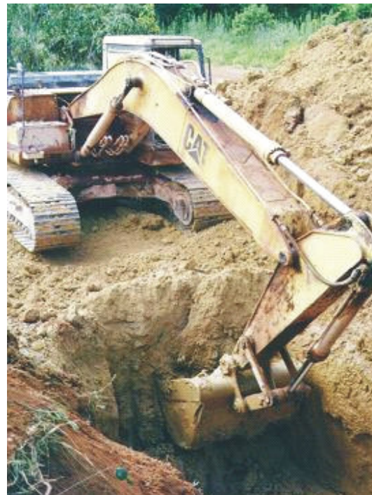
FIGURA 26 - Escava carregadora na construção de estruturas hidráulicas
