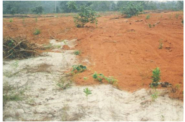
FIGURA 24 - Rejeito arenoso capeado
