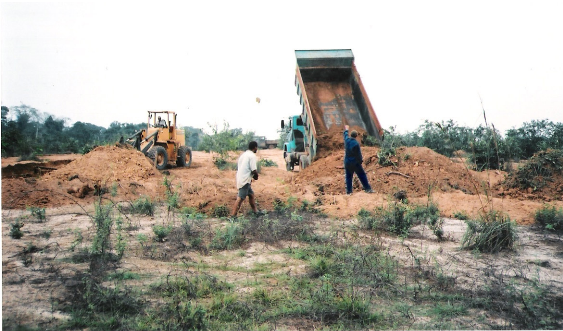
FIGURA 12 - Rejeito arenoso sendo capeado com substrato argiloso
