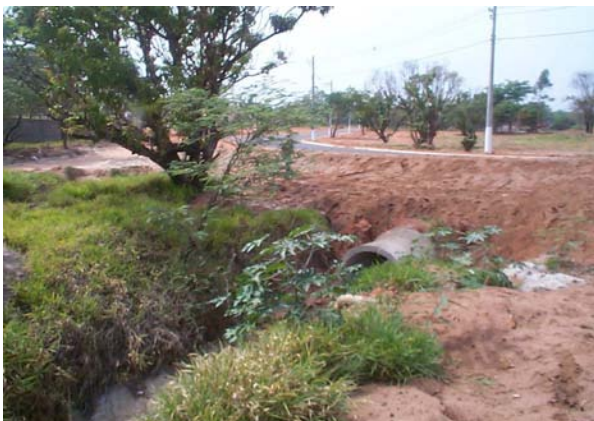
Foto 8.20 e Foto 8.21: Evolução da voçoroca do Residencial Chácara Odete e obras paliativas como solução emergencial (Fonte: F. N. CORGHI, 2003, 2004)
