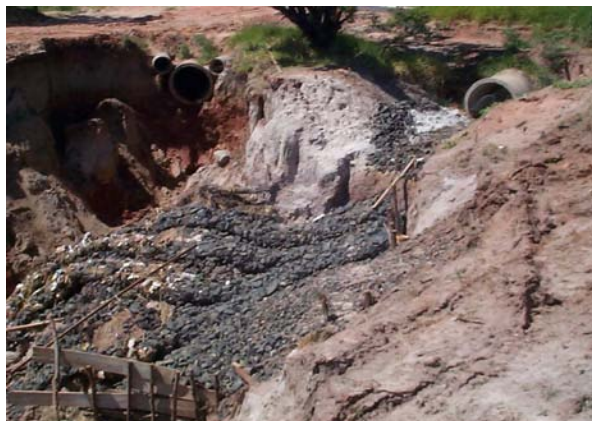
Foto 8.20 e Foto 8.21: Evolução da voçoroca do Residencial Chácara Odete e obras paliativas como solução emergencial (Fonte: F. N. CORGHI, 2003, 2004)
