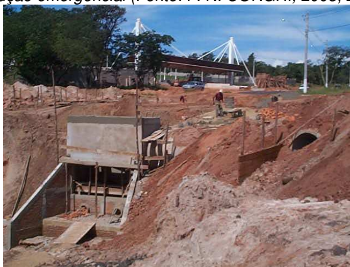
Foto 8.22: Instalação dos dissipadores de energia em frente à Av: Antenor de Almeida, de acordo com o projeto de contenção das erosões (Fonte: F. N. CORGHI, abr. 2004)
