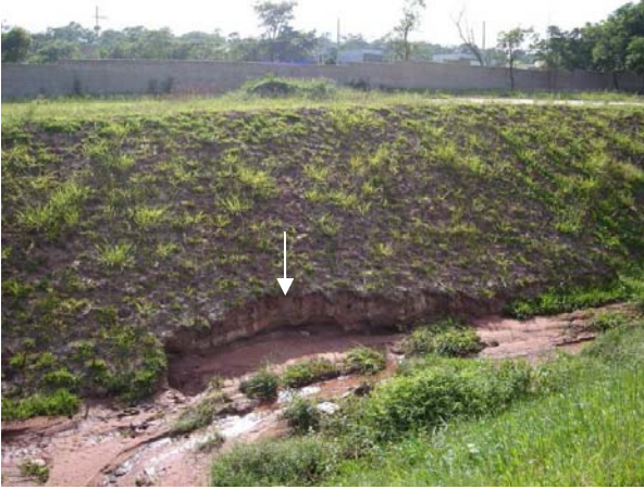
Foto 8.26 e Foto 8.27: Assoreamento do canal e Incisões no terreno ao lado do cachimbo nas obras da erosão do residencial Chácara Odete (Fonte: CORGHI et. al., 2008)
