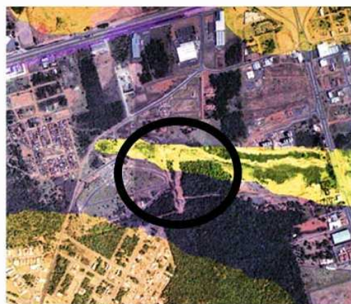
Figura 8.9: Cabeceira do Córrego da Água Comprida com destaque às ocupações urbanas, erosões, antes das obras de correção, e nascente do córrego na cor azul (Fonte: F. N. CORGHI, 2005)
