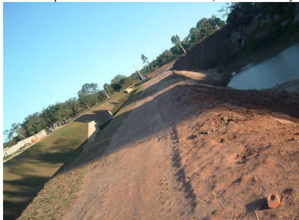
Foto 8.23 e Foto 8.24: Obras de retificação do leito do córrego (parceria entre prefeitura e particulares), onde o esgoto foi canalizado do lado direito da foto e a mina d'água foi inicialmente represada e, depois drenada para se aterrar a voçoroca (Fonte: F. N. CORGHI, 2005)
