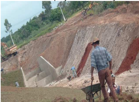
Foto 8.23 e Foto 8.24: Obras de retificação do leito do córrego (parceria entre prefeitura e particulares), onde o esgoto foi canalizado do lado direito da foto e a mina d'água foi inicialmente represada e, depois drenada para se aterrar a voçoroca (Fonte: F. N. CORGHI, 2005)
