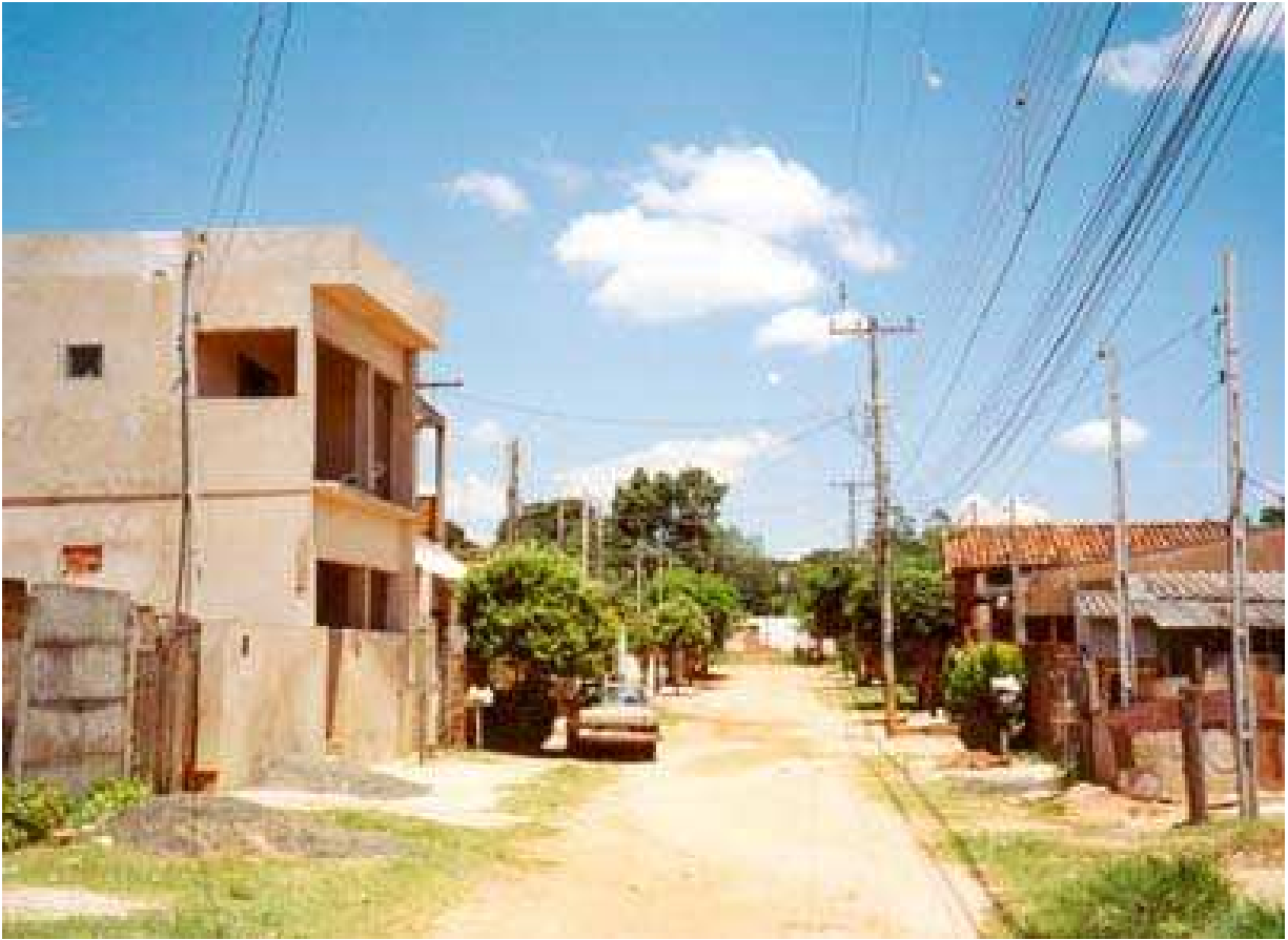
Foto 8.8: Infra-estrutura adquirida informalmente por esforços dos próprios moradores do Nicéia (ALVES et. al., 2004, p. 6)
