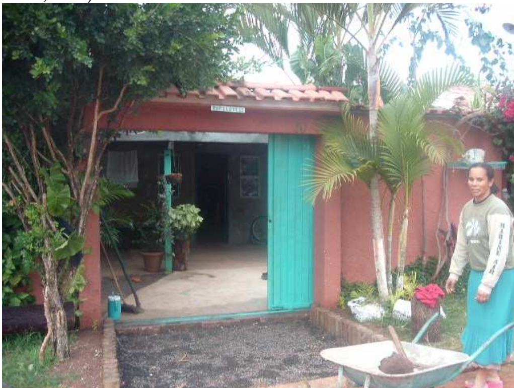
Foto 8.3: Moradora levando materiais de construção para sua residência (Fonte: F.N. CORGHI, 2005)
