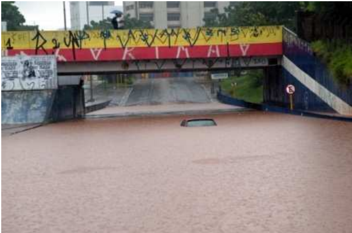
Foto 7.3: Avenida Nações Unidas alagada na altura da Antártica (Fonte: JORNAL DA CIDADE, 2005)
