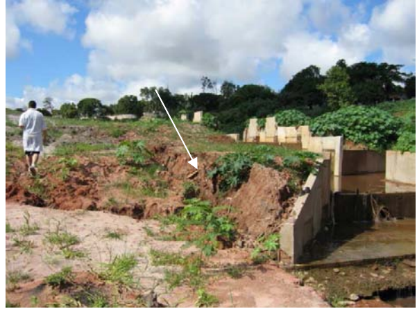
Foto 8.26 e Foto 8.27: Assoreamento do canal e Incisões no terreno ao lado do cachimbo nas obras da erosão do residencial Chácara Odete (Fonte: CORGHI et. al., 2008)
