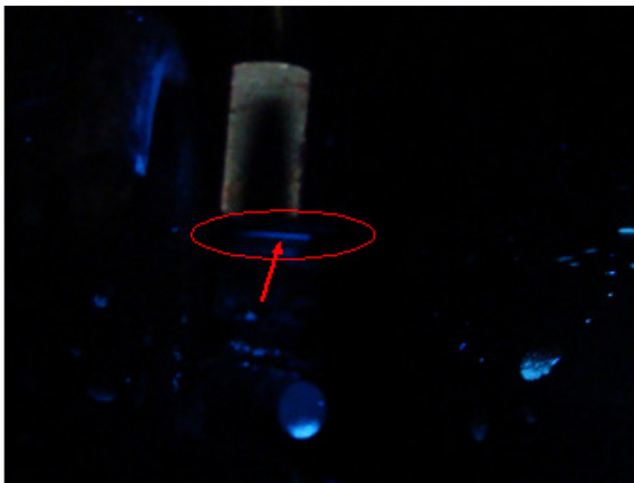
Figura 57: Vazamento entre tubo e “rail” verificado pela contorno azulado
