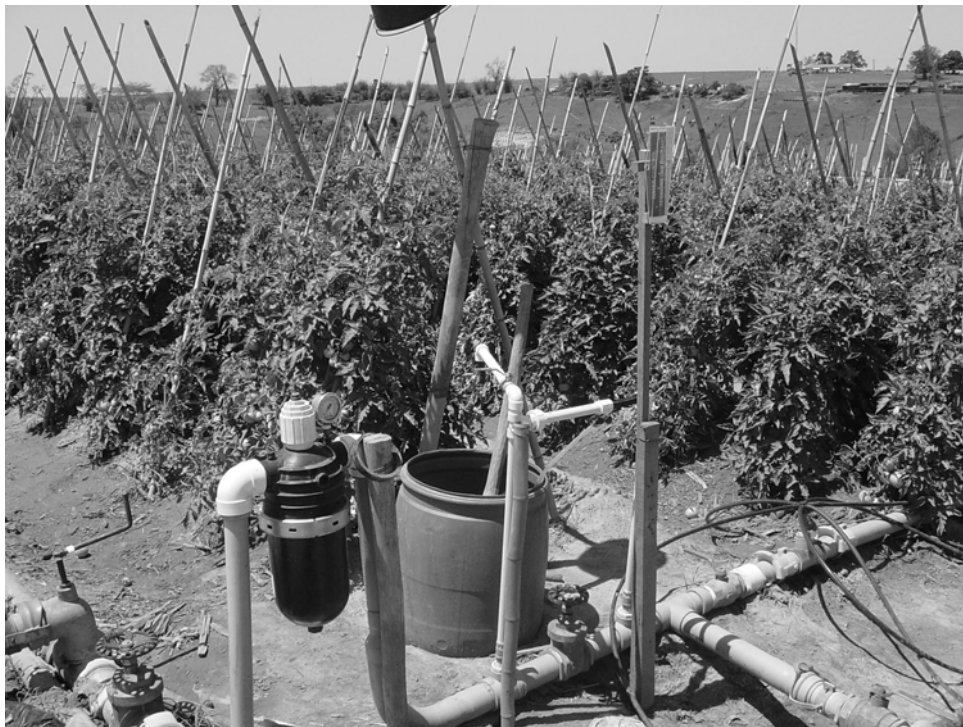
Figura 4. Cabeçal de controle utilizado no tratamento TG.
