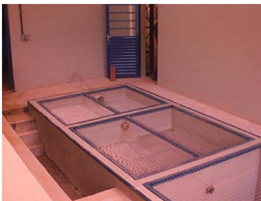
FIGURA 3.13 Tanque de evaporação para tratamento de efluentes
