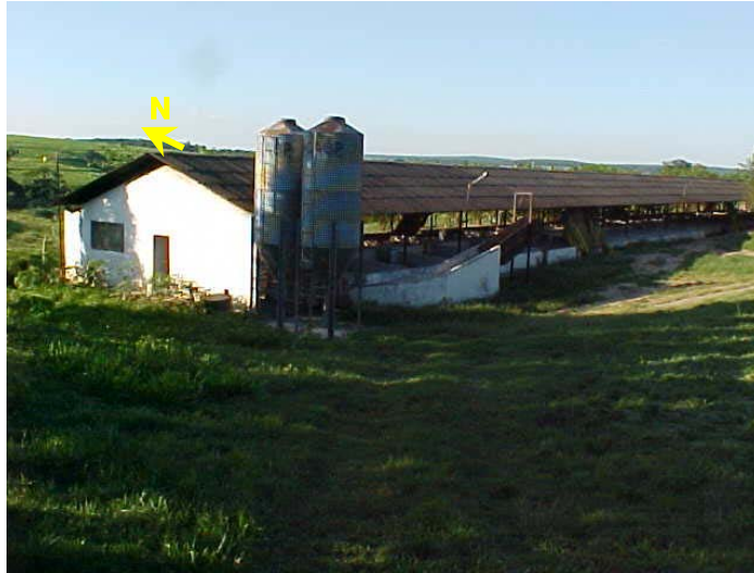
Figura 11. Vista do galpão para terminação.
