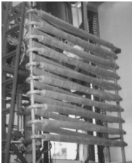
Figura 32. Condensador de amônia por convecção natural com o ar.
