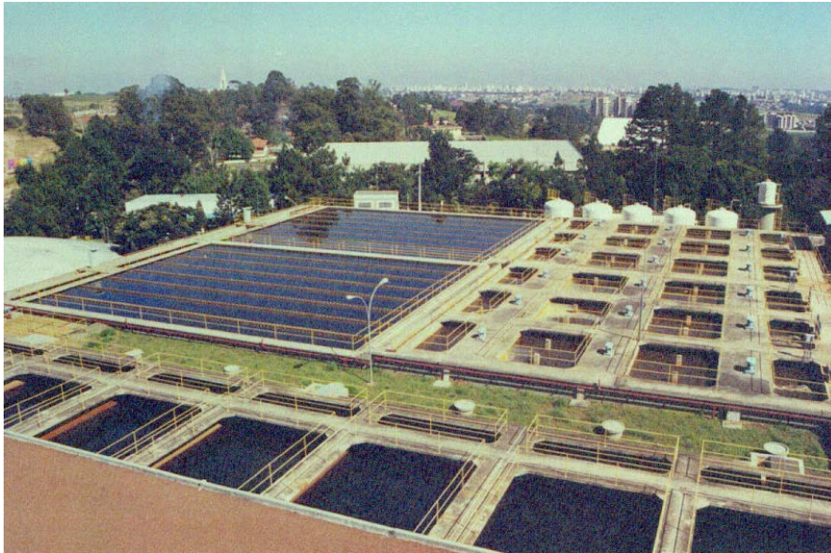
Figura 3a: Decantadores e filtros da ETA 4.
