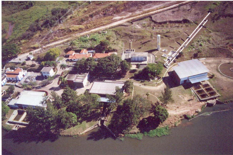
Figura 2a: Captação do Rio Atibaia - Campinas (vista aérea).
