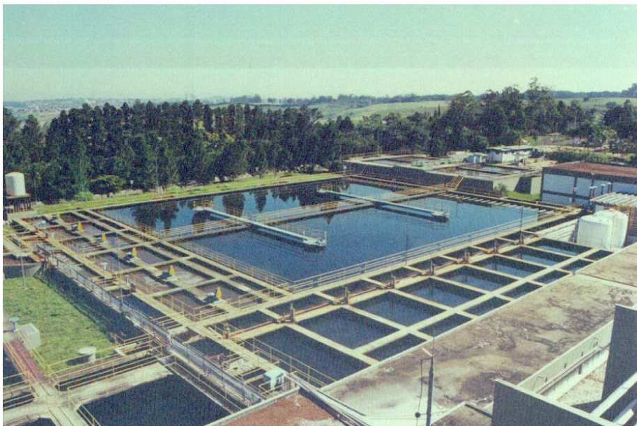
Figura 3b: Decantadores e Filtros da ETA 3.
