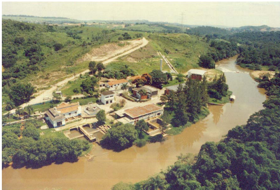
Figura 2b: Captação do Rio Atibaia – Campinas (vista aérea).
