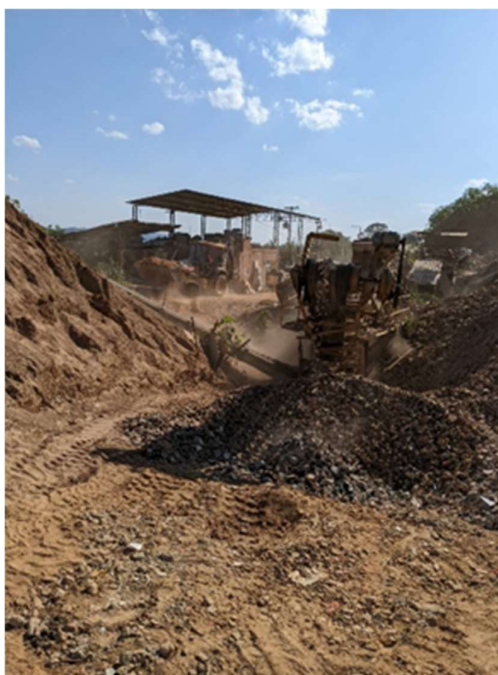
Figura 67- Usina de reciclagem em operação com restrição de espaço.
